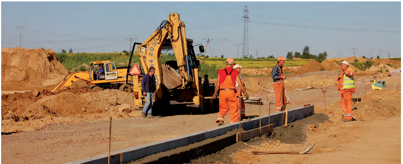
Budowa ulicy Gdańskiej
