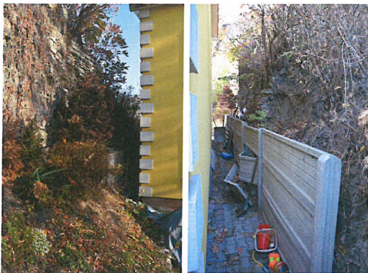
Widok muru na działce nr 130 oraz zniszczony murek oporowy
